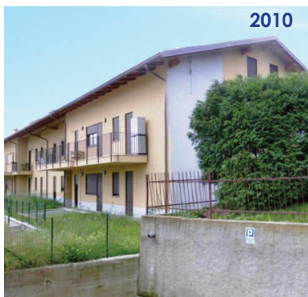
Arona (NO) Mercurago via Petrarca 12 alloggi Edilizia Convenzionata
