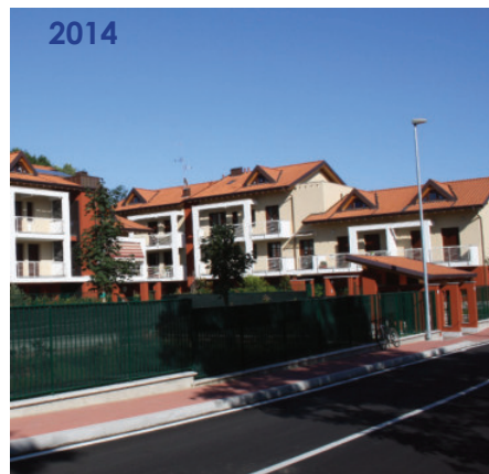
2014 Marnate (VA) Via Morelli - 3 Edifici 34 alloggi di Ed. Convenzionata
