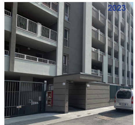
2023 MILANO Via A. Meucci, 47 ed. C - D 26 alloggi di Ed. Convenzionata
