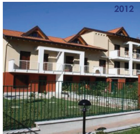
MARNATE (VA) via Morelli edificio 1B 1° lotto 11 alloggi di edilizia conv. 2° lotto 11 alloggi di edilizia conv. 3° lotto 13 alloggi di edilizia conv.
